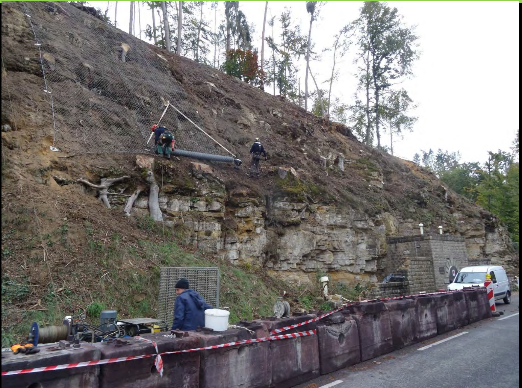
Felssicherung mittels Sicherheitsnetzen
